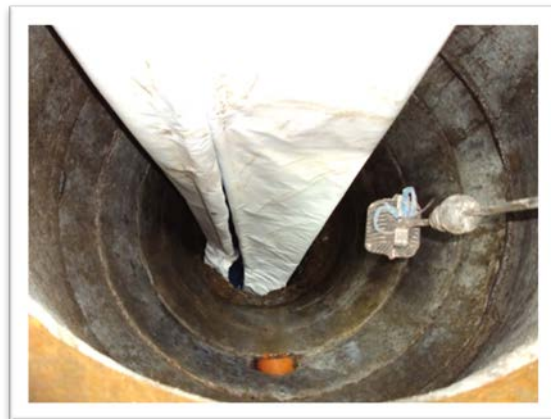
Vakka-Suomenkadun viemärin saneeraus ns. sukkasujutus menetelmällä. "Sukka" sujutetaan viemäriin
